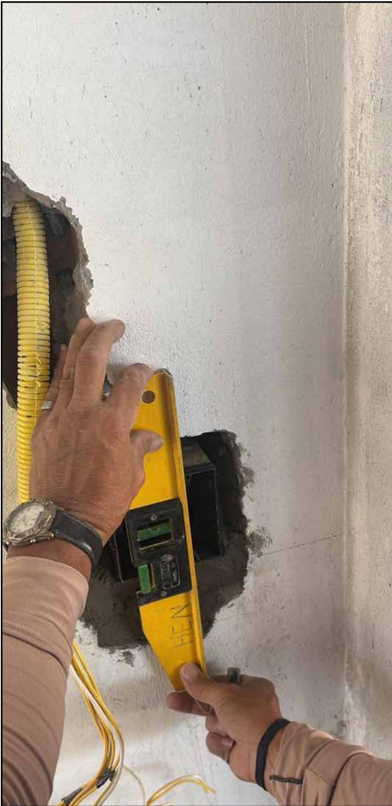
CHUMBAMENTO DE CAIXINHA ELÉTRICA
