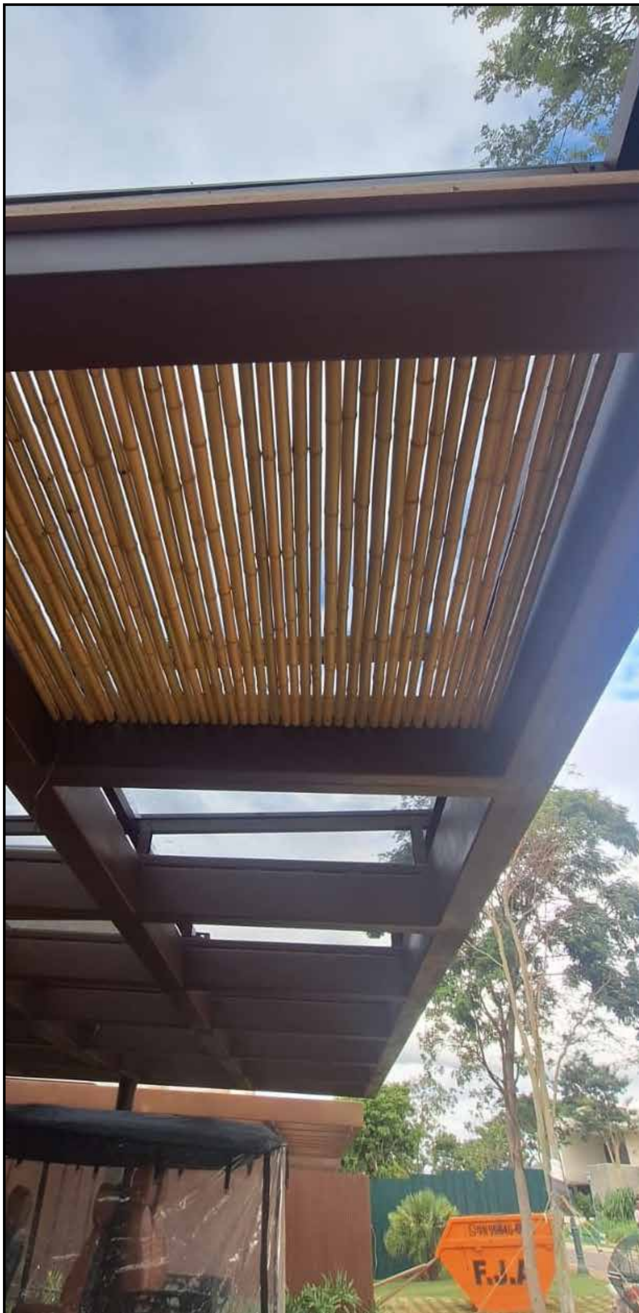
INST. FORRO DE BAMBU
