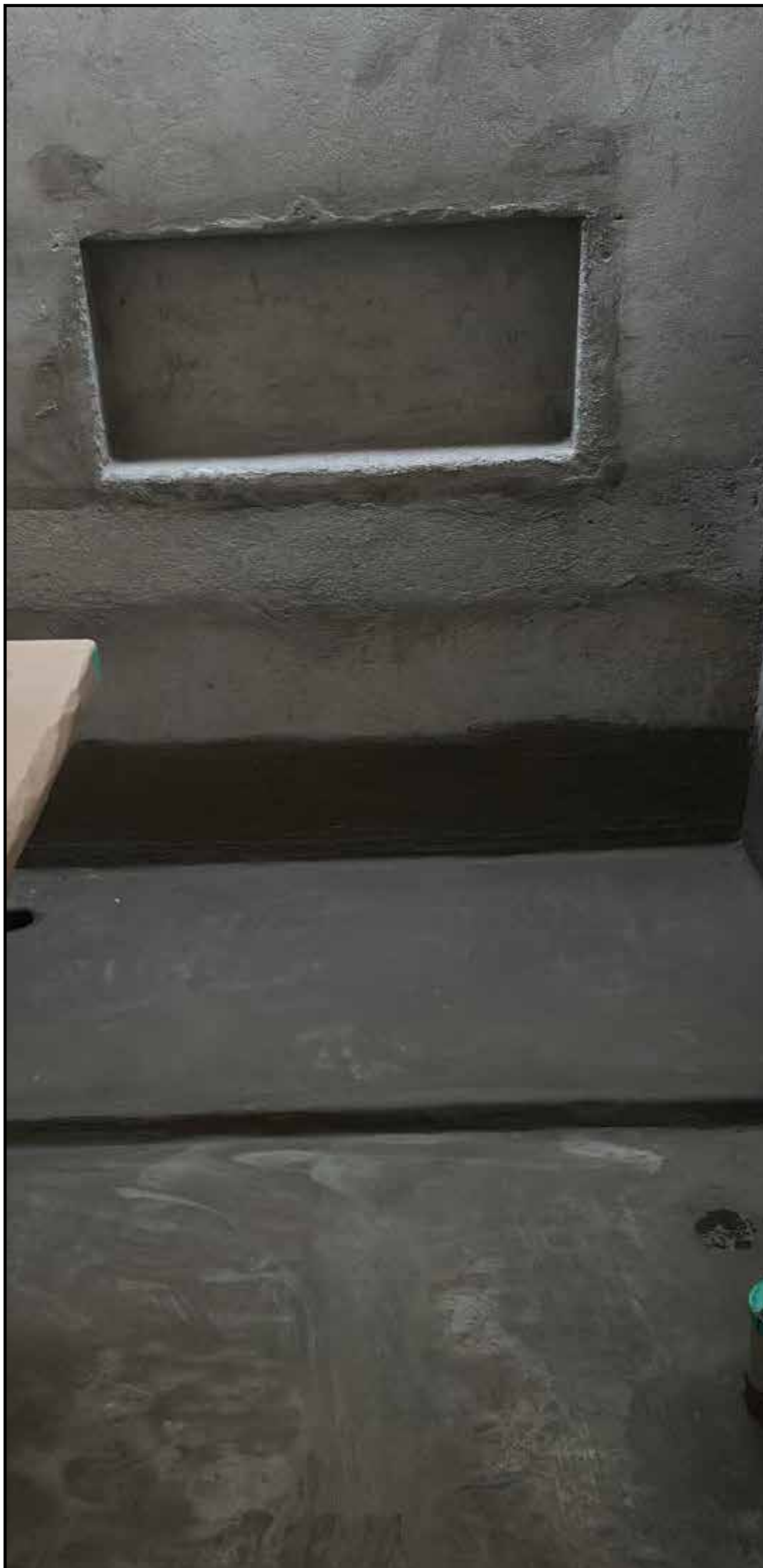
IMPERMEABILIZAÇÃO BANHO BERNARDO
