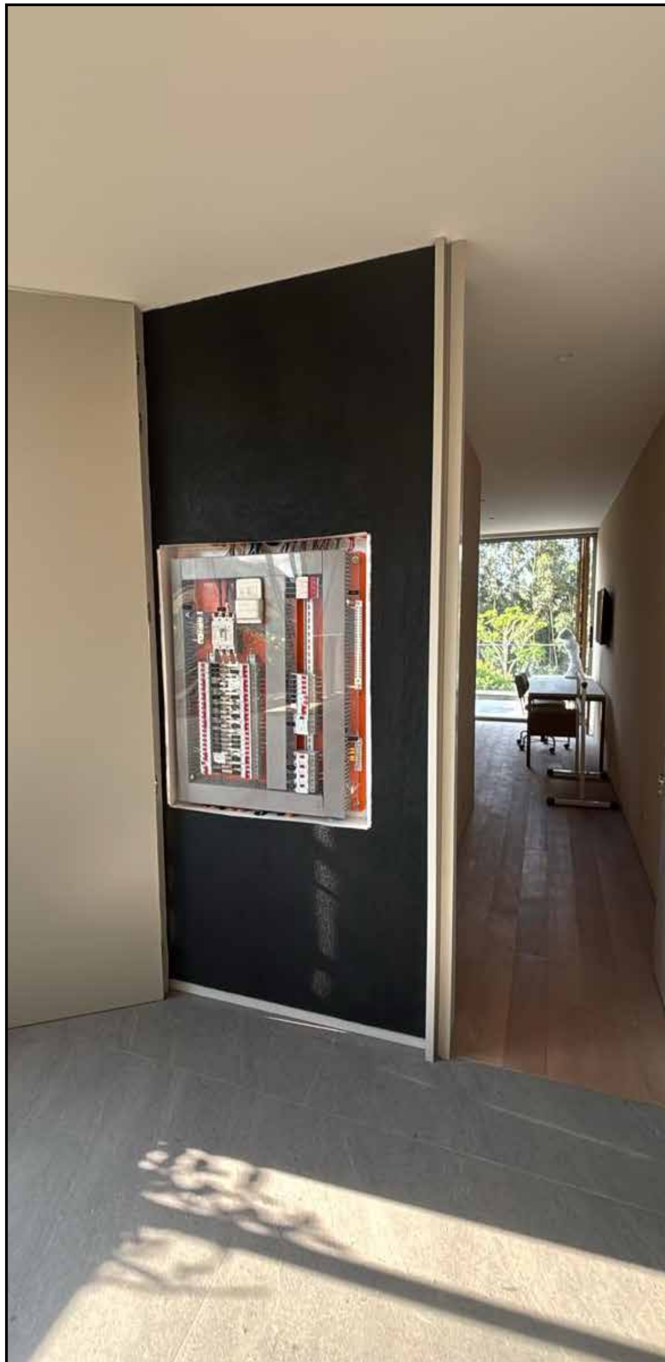
PINTURA QUADRO ELÉTRICO HOME THEATER
