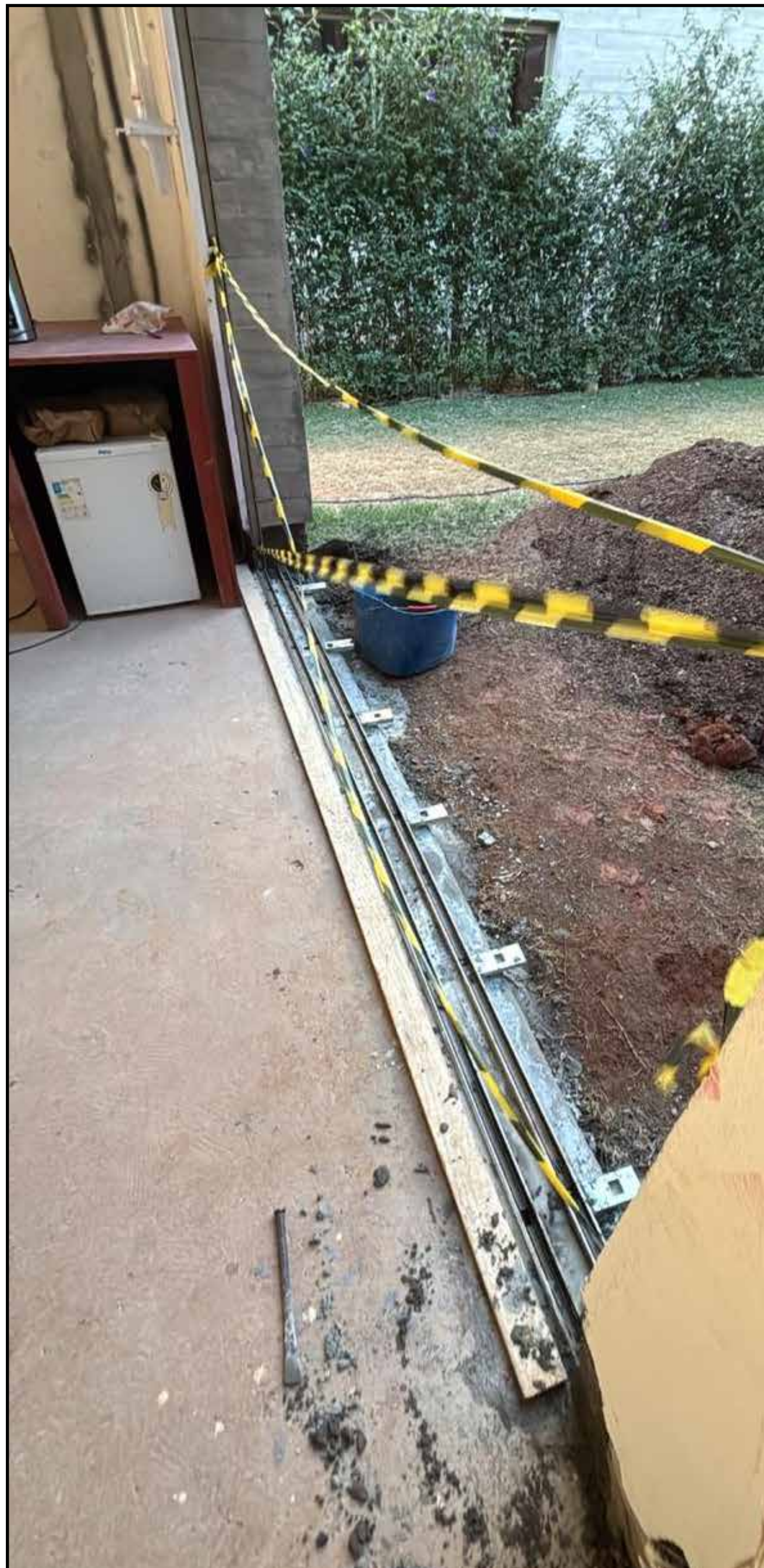
ENCHIMENTO TRILHO CAIXILHO SALA TV
