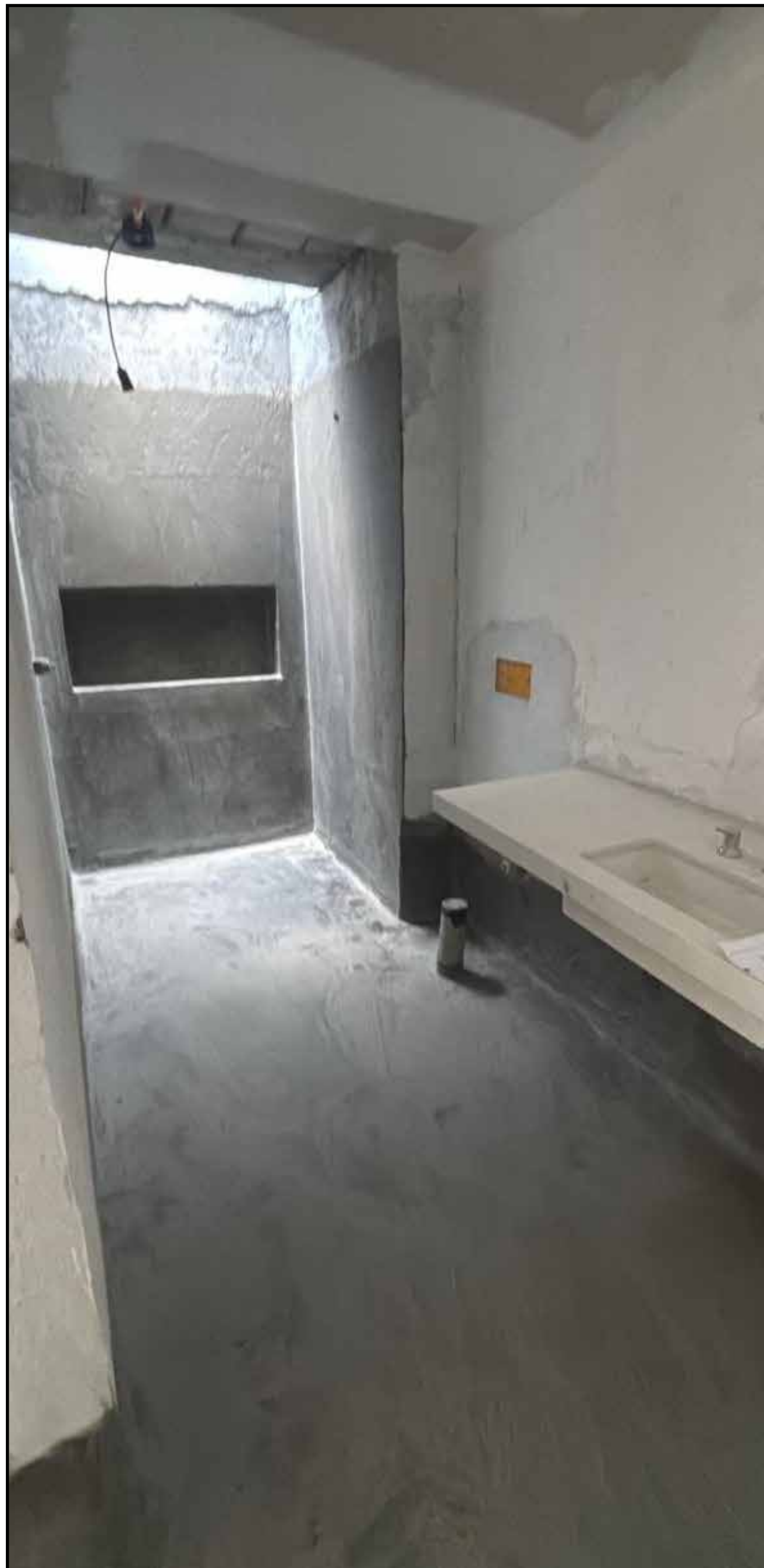
IMPERMEABILIZAÇÃO BANHO HÓSPEDES
