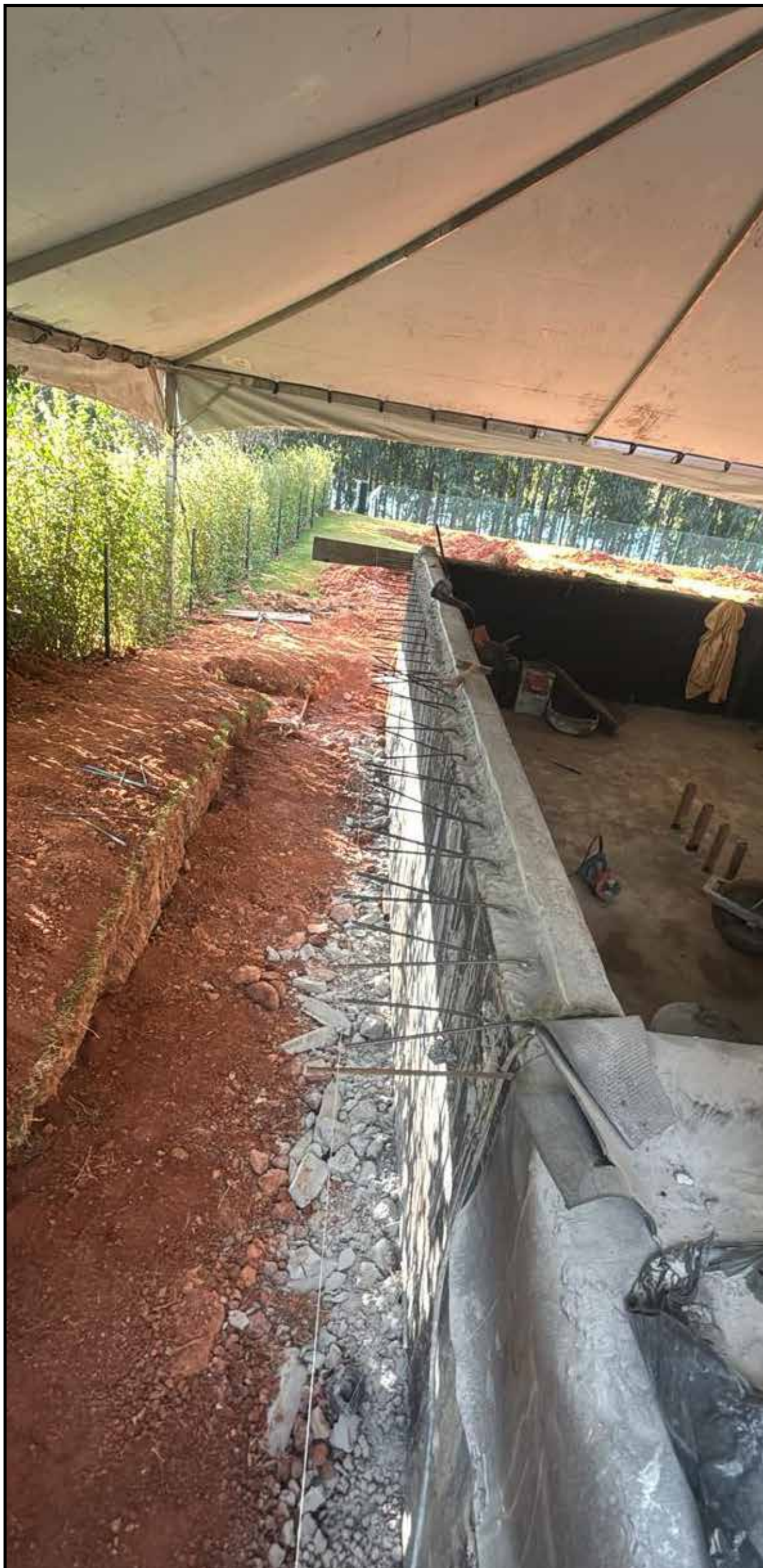
EXEC.ARRANQUES LAJE BORDA PISCINA
