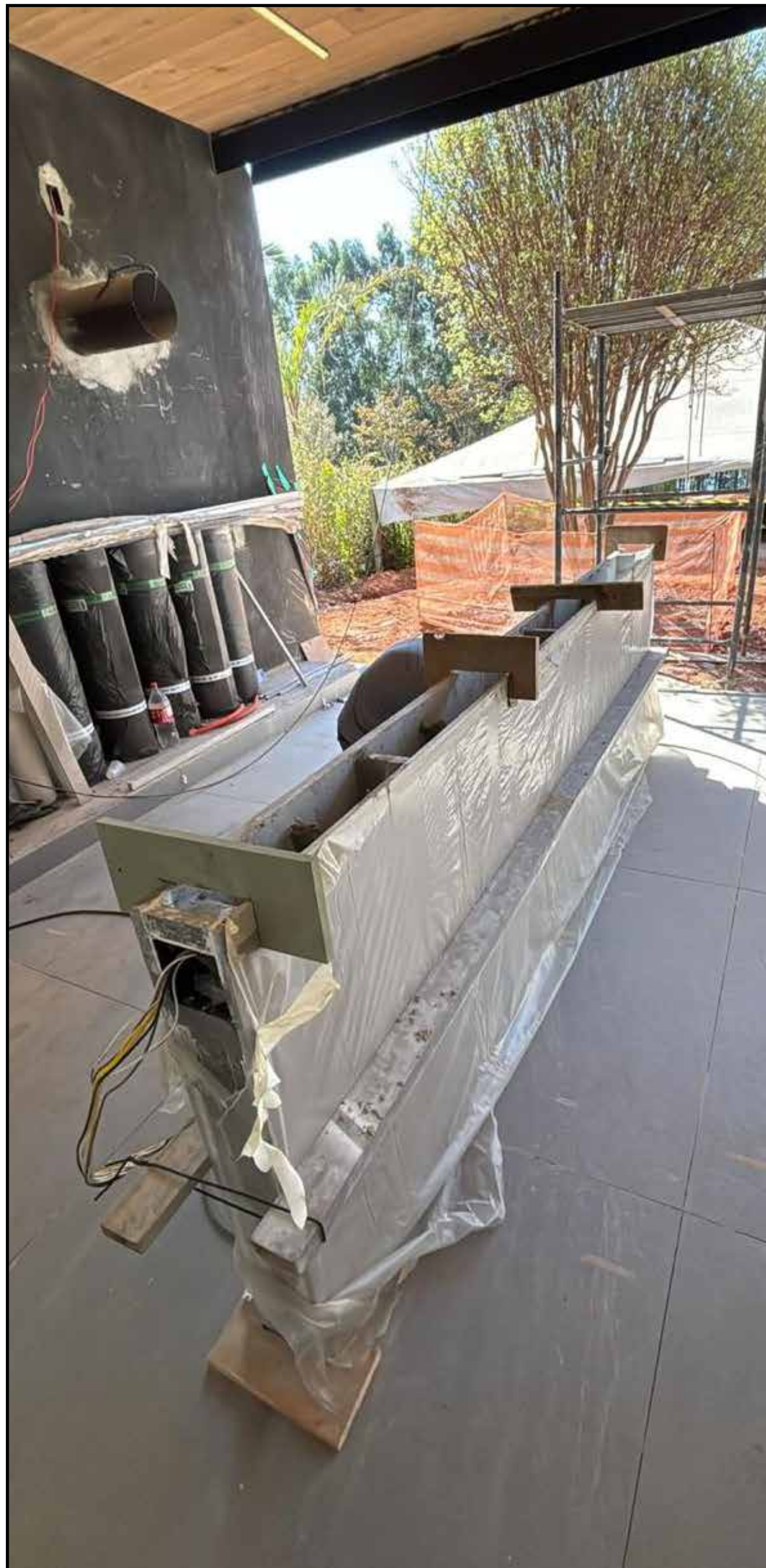
EXEC. ESTRUTURA ILHA GOURMET
