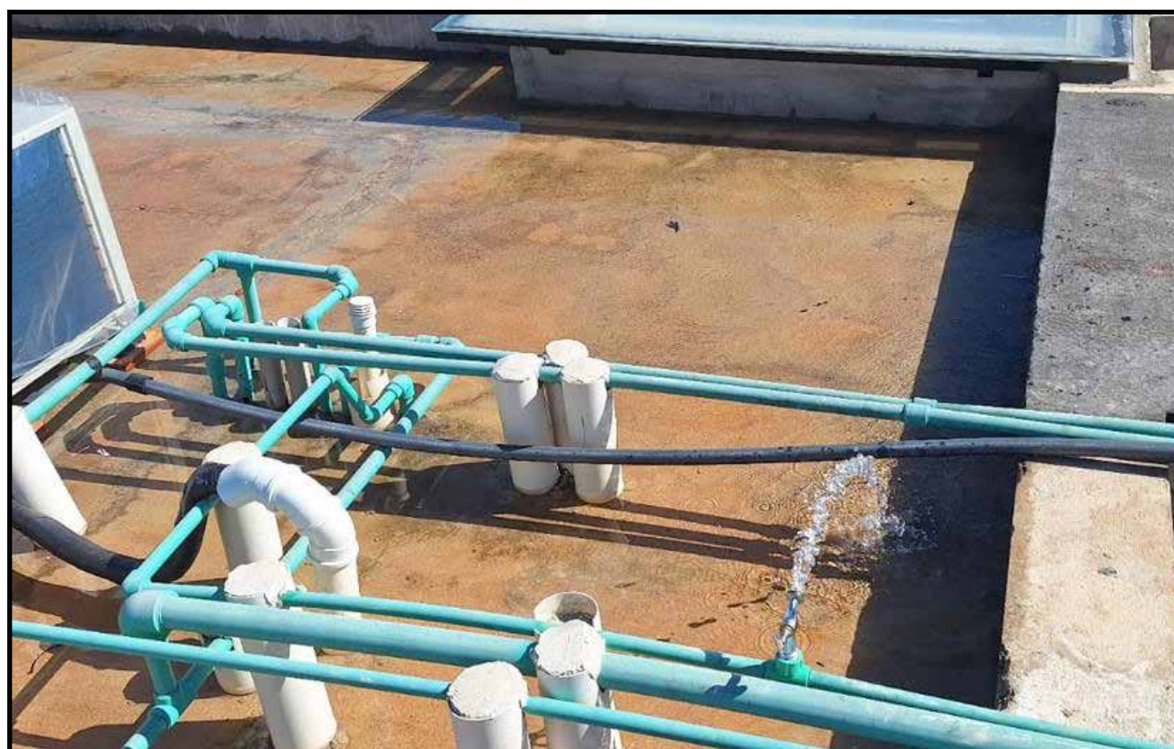
TESTE DE ESTANQUEIDADE LAJE DE COBERTURA B
