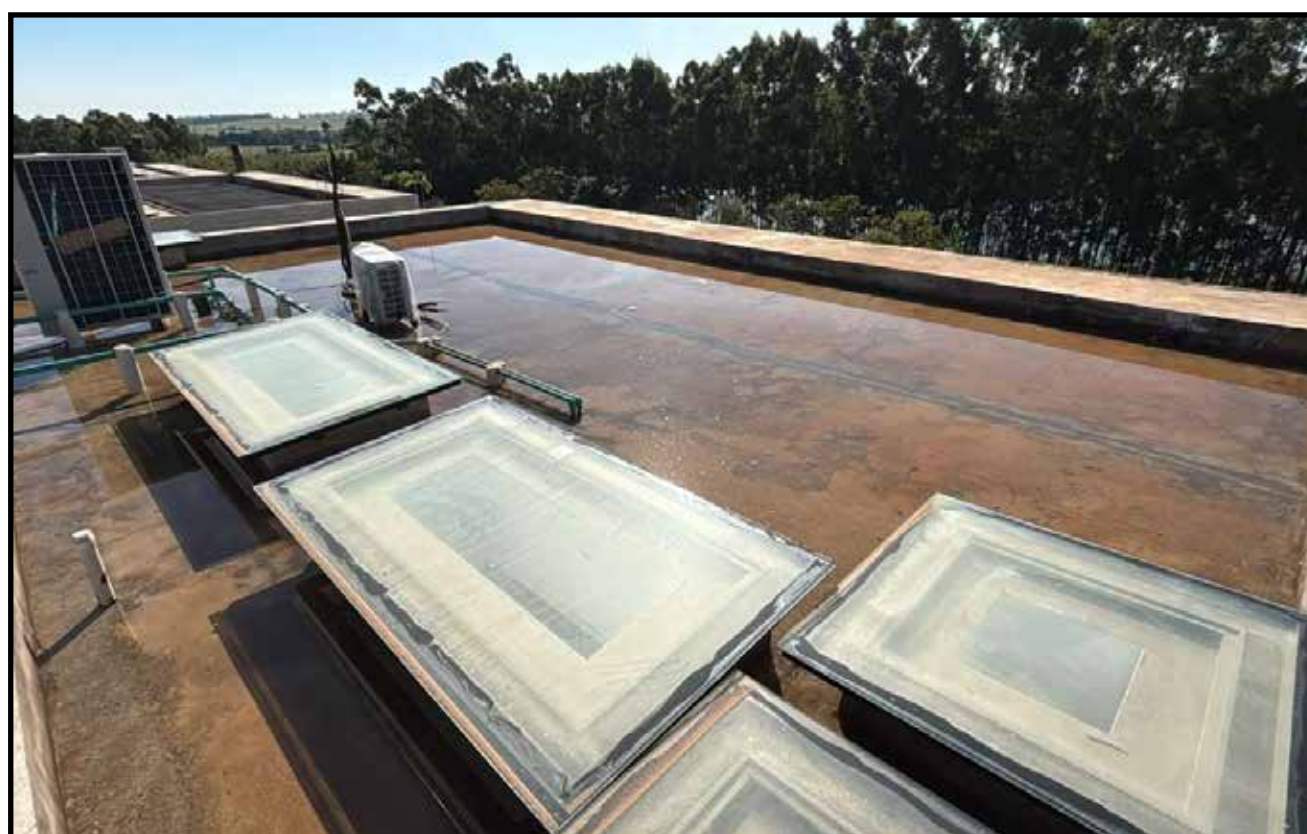
TESTE DE ESTANQUEIDADE LAJE DE COBERTURA
