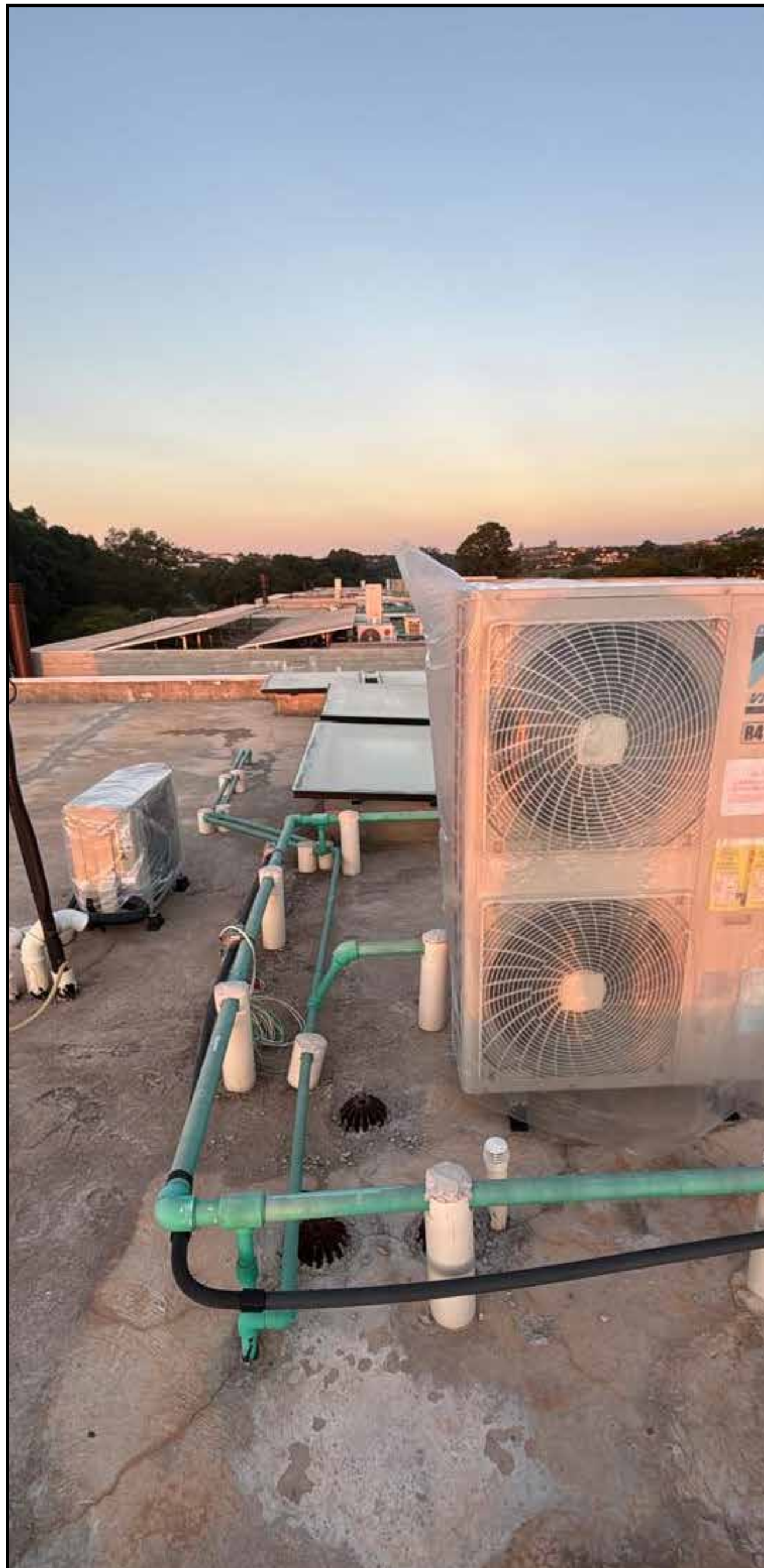
INST. CONDENSADORA COBERTURA
