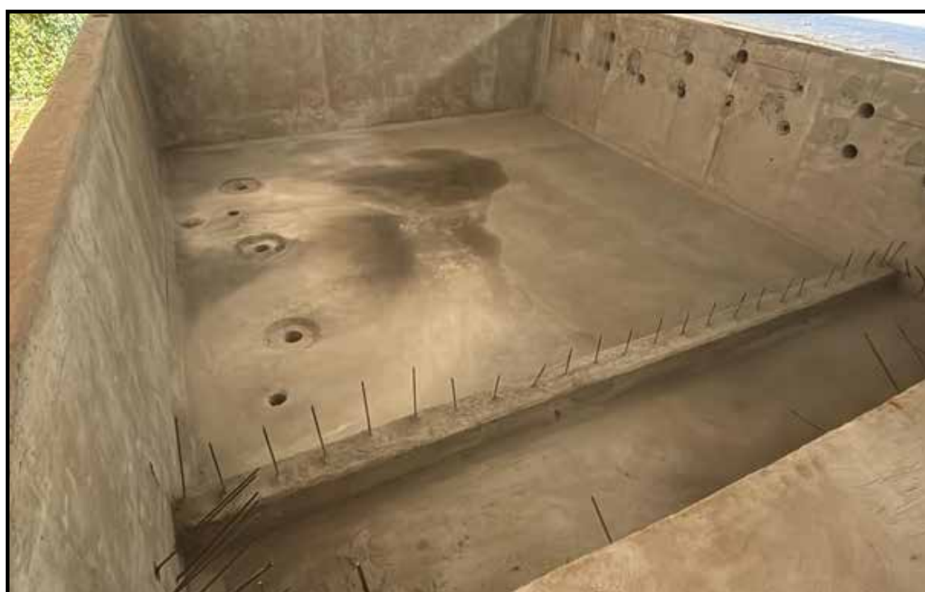
REGULARIZAÇÃO E ARRANQUES PISCINA
