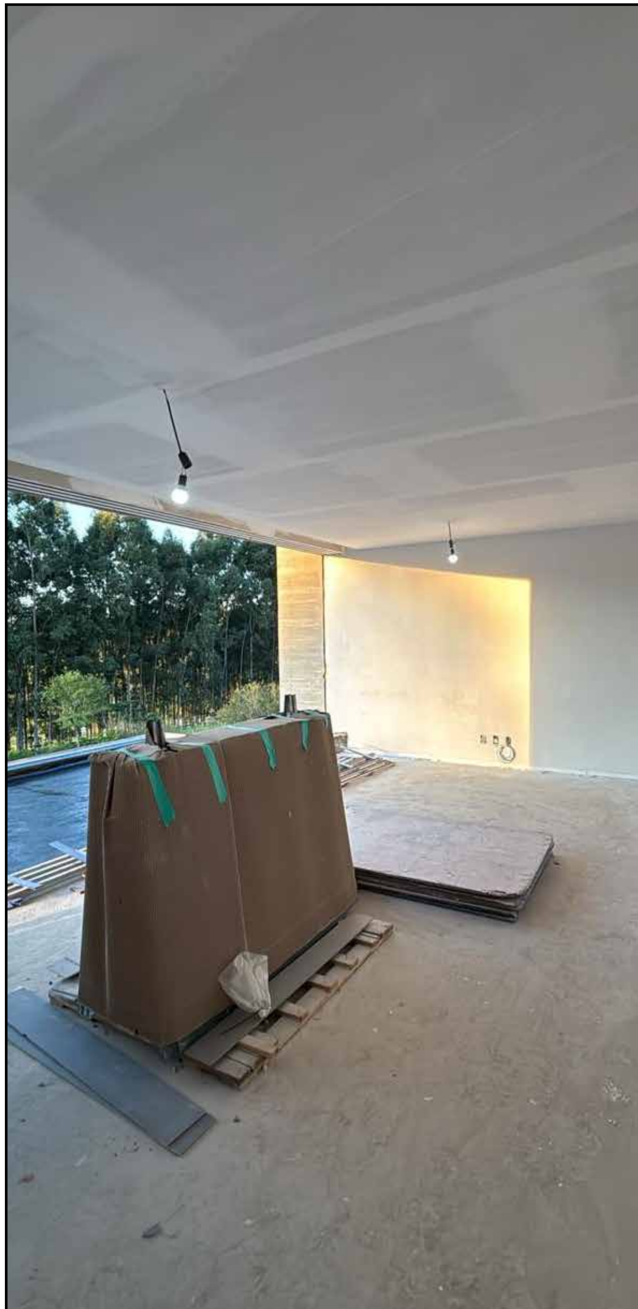
EXEC. MASSA CORRIDA FORRO SUÍTE MASTER
