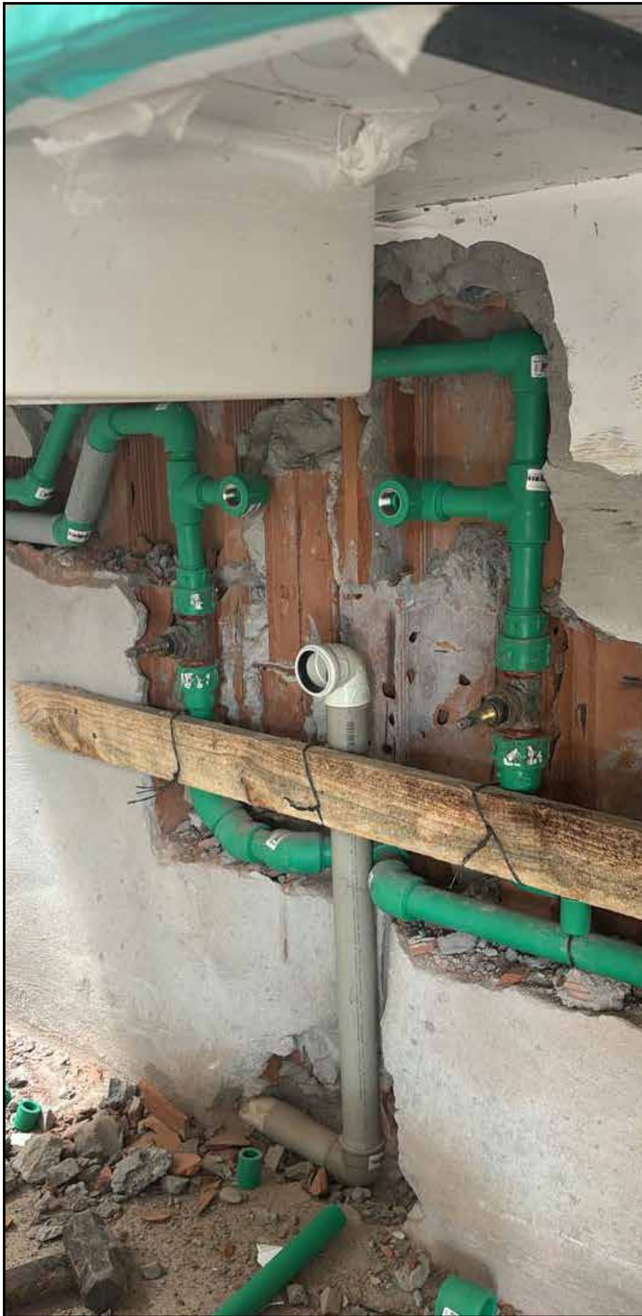
EXEC. INFRA HIDRÁULICA BANHO
