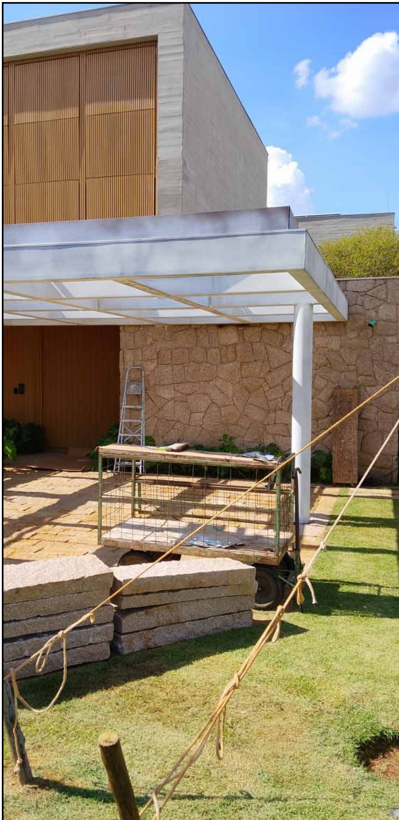
PINTURA PERGOLADO F
