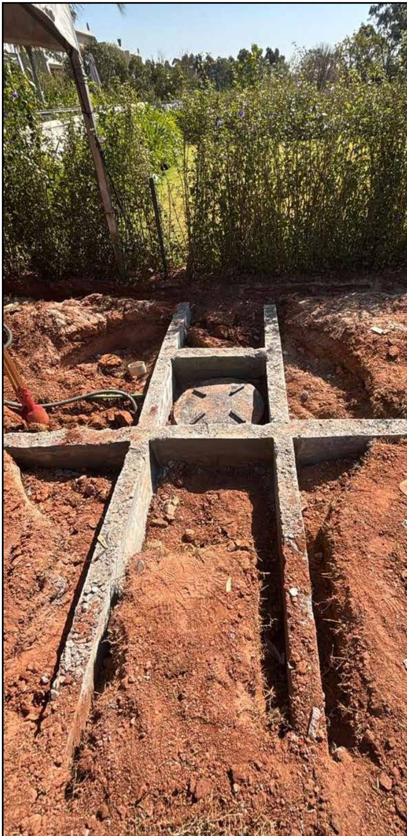
EXEC. ESTRUTURA CISTERNA
