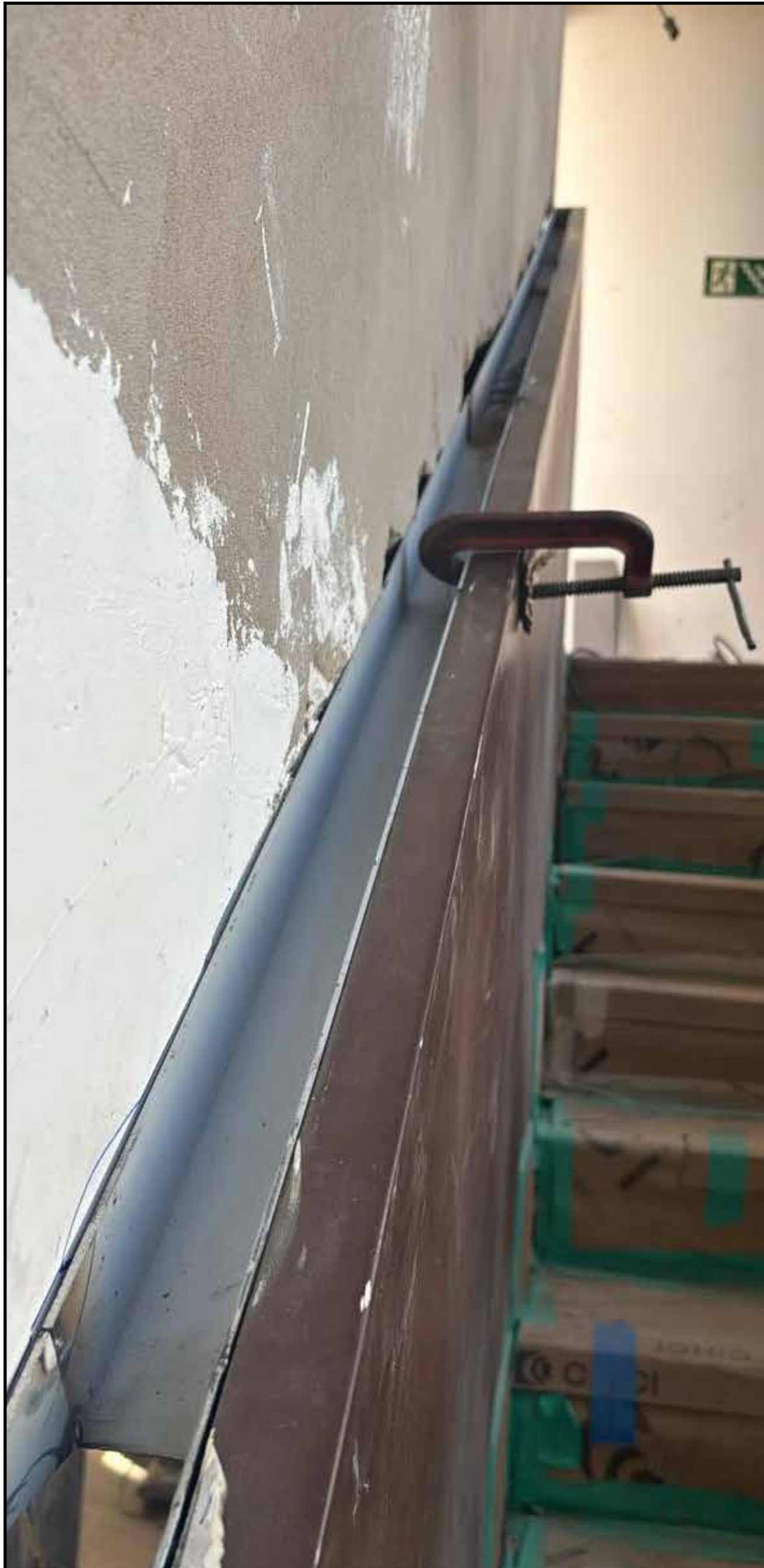
INST.ACABAMENTO CORRIMÃO ESCADA
