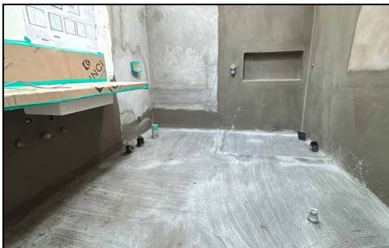
PROTEÇÃO MECÂNICA BANHO MASTER
