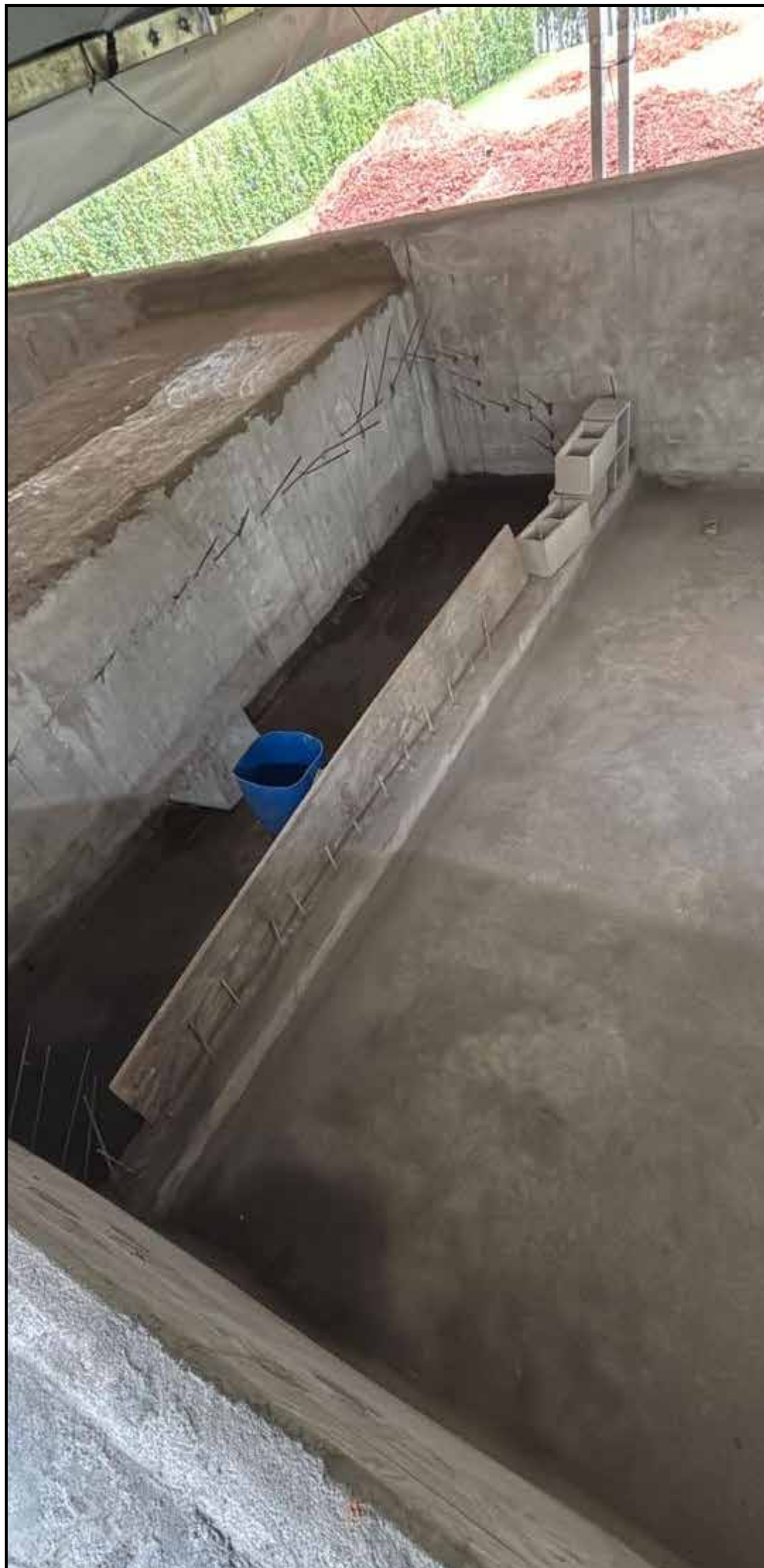
REGULARIZAÇÃO PISO PISCINA
