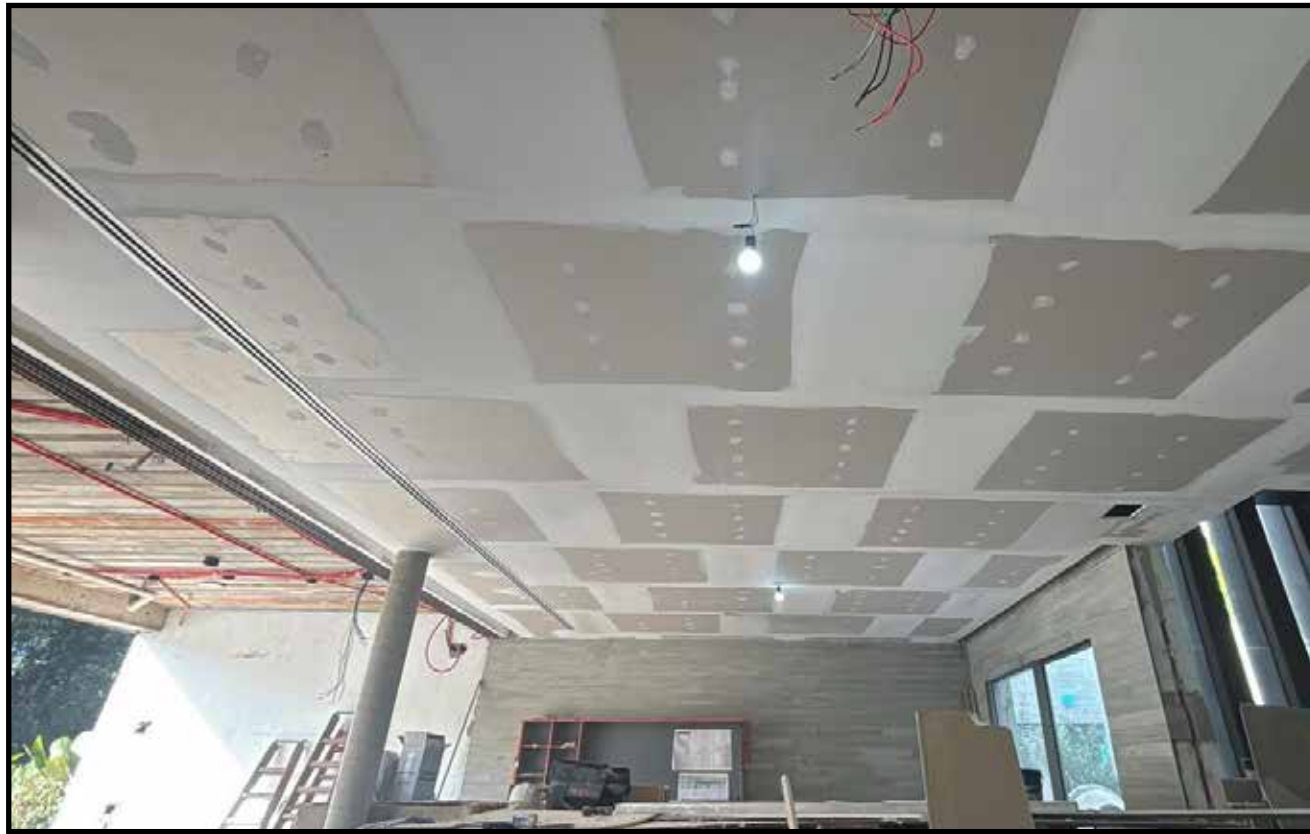
INST. FORRO SALAS
