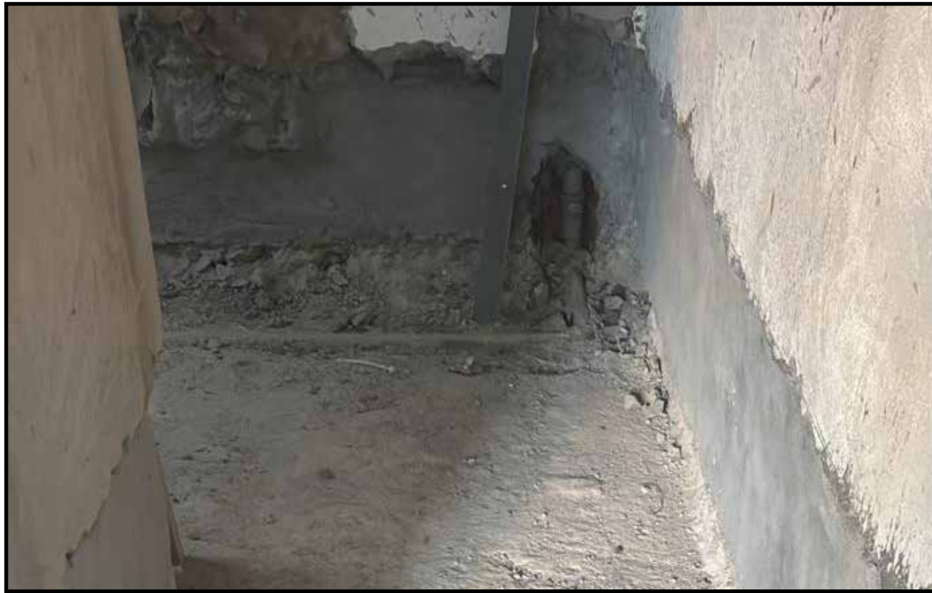
INST. RIPAS DE CONCRETO SALA DE TV
