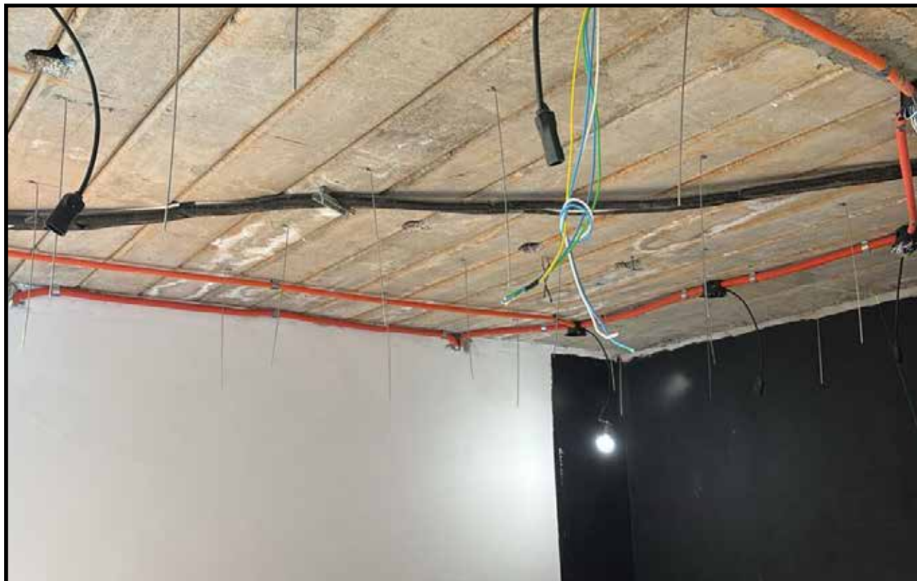
ESTRUTURA FORRO E PINTURA SUÍTE HÓSPEDES
