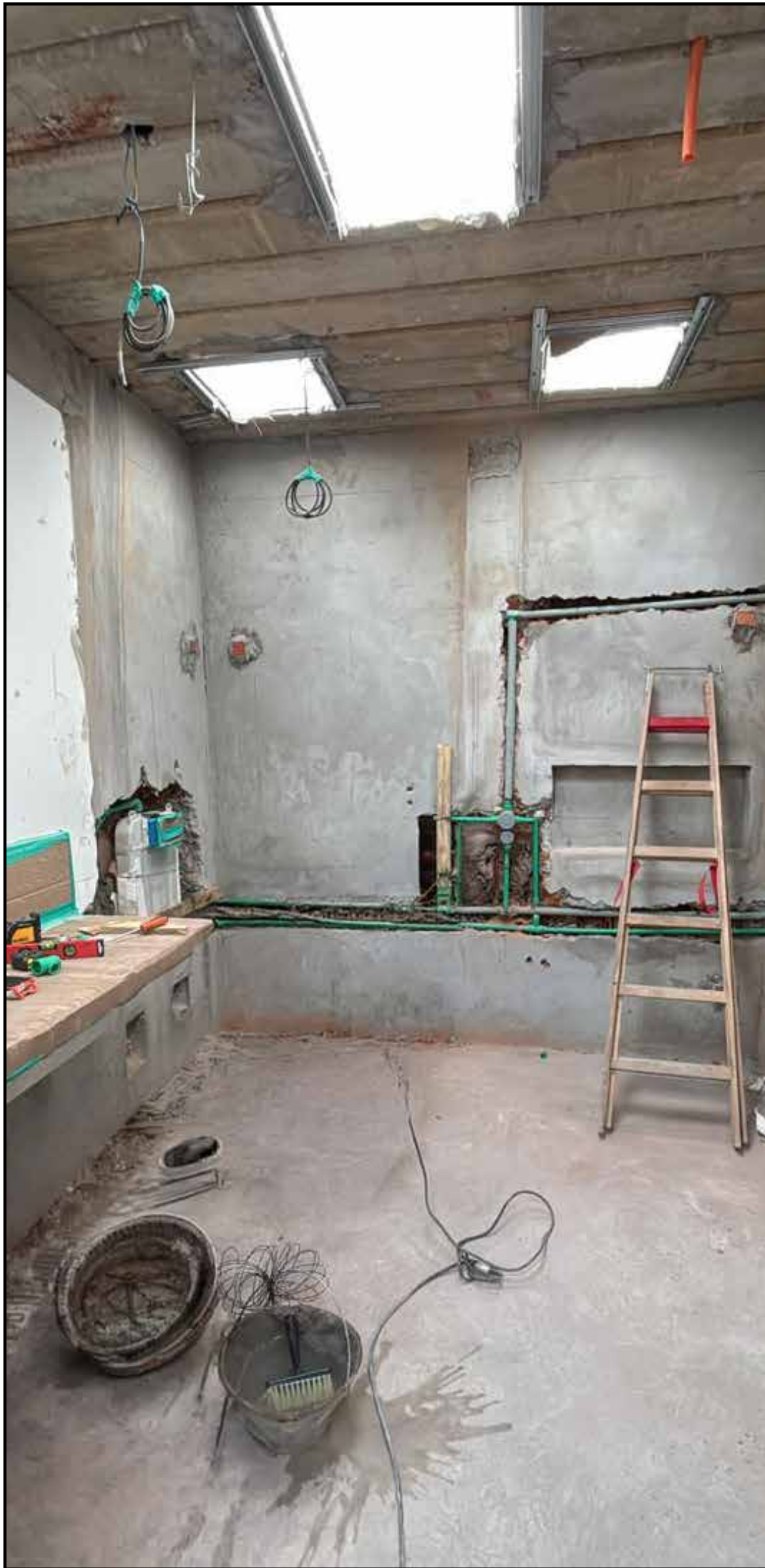
EXEC. INFRA HIDRÁULICA BANHO MASTER
