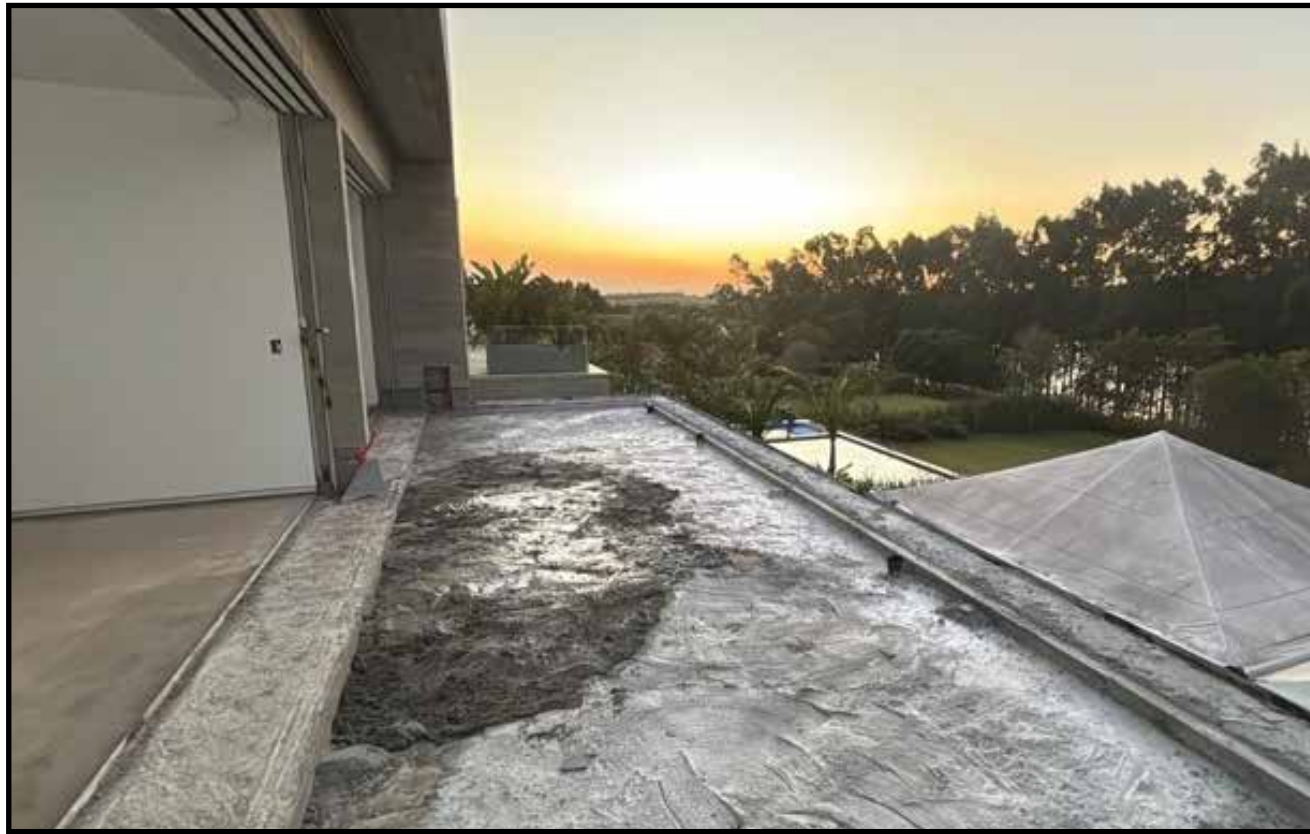
BASES GUARDA-CORPO E CONTRAPISO VARANDA
