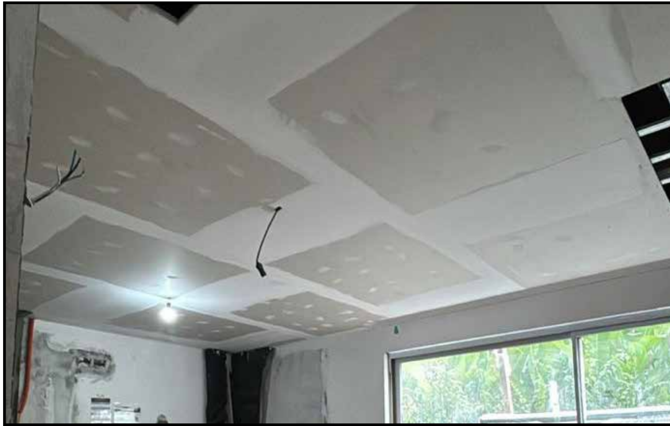
INST. FORRO COZINHA
