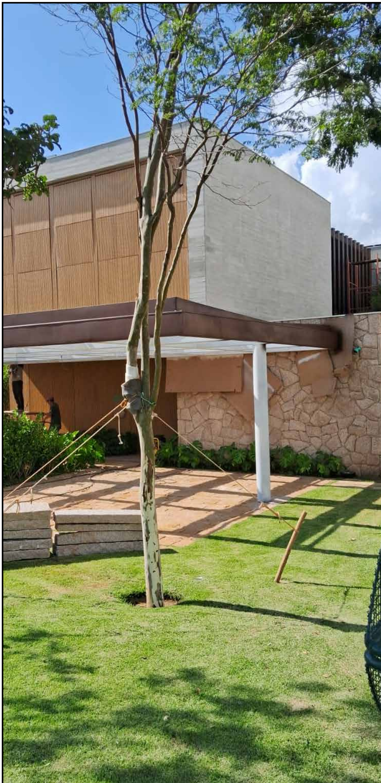
PINTURA PERGOLADO G
