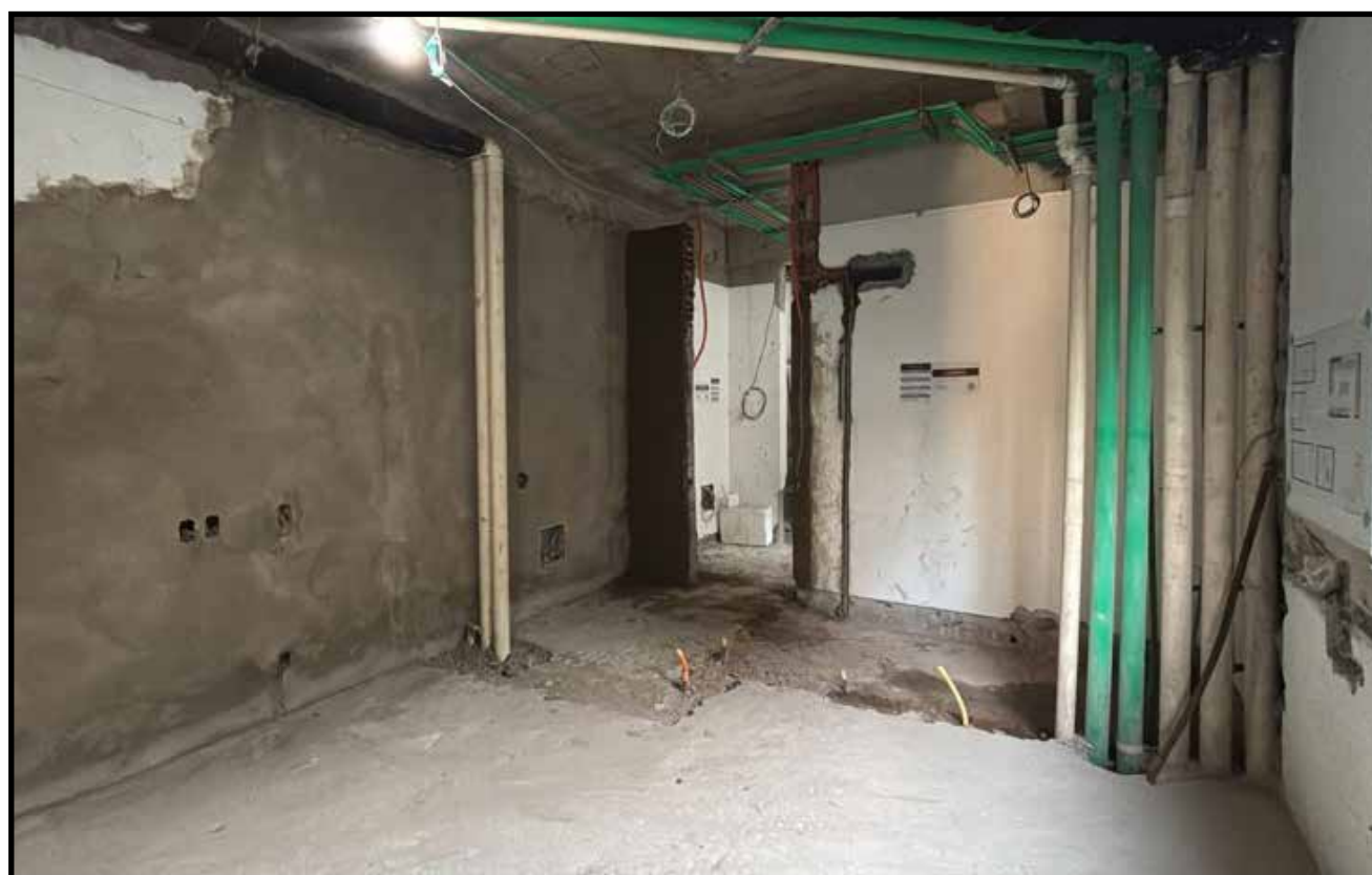
REGULARIZAÇÃO ALVENARIA COZINHA
