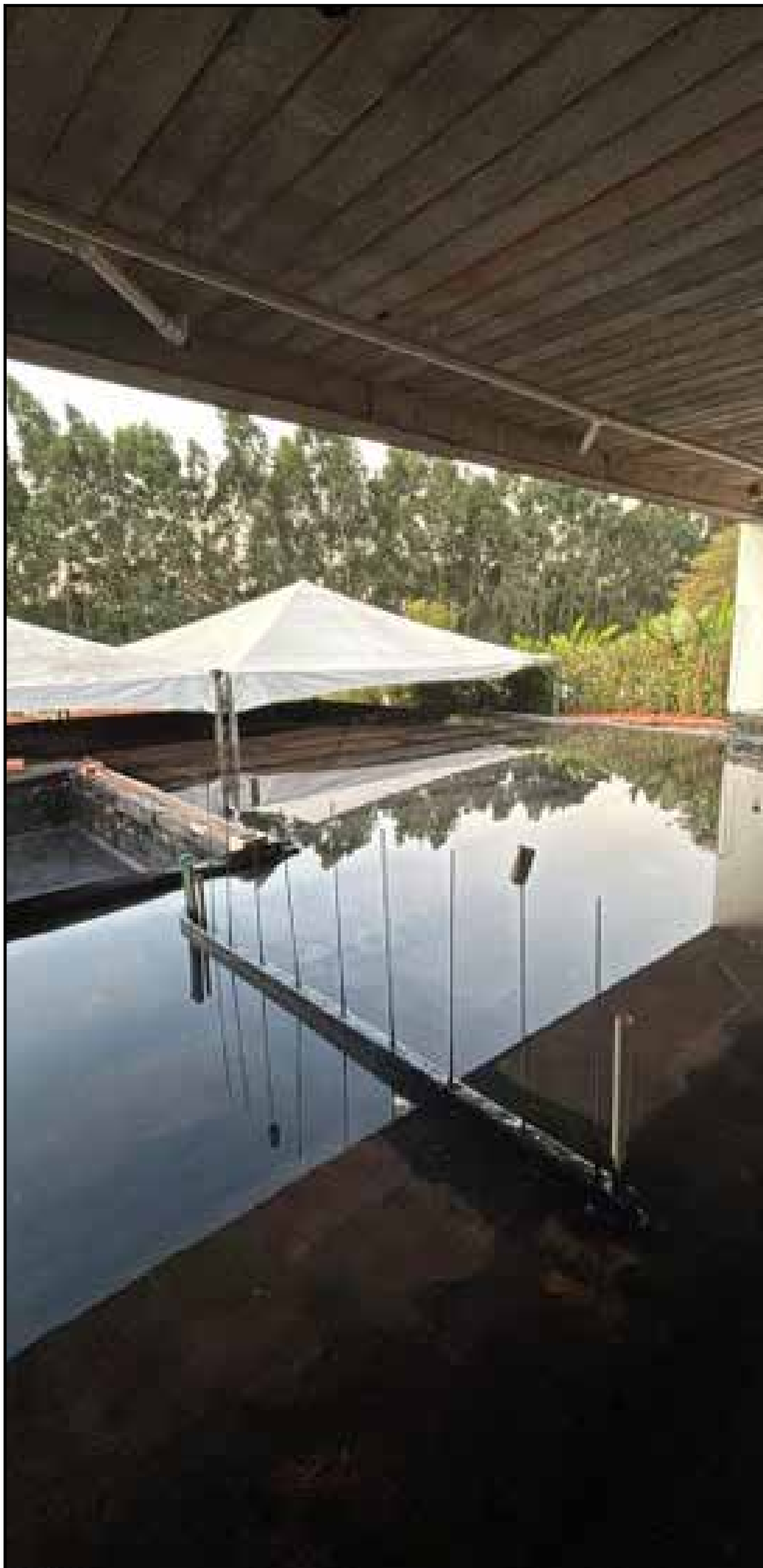
TESTE DE ESTANQUEIDADE GOURMET E DECK
