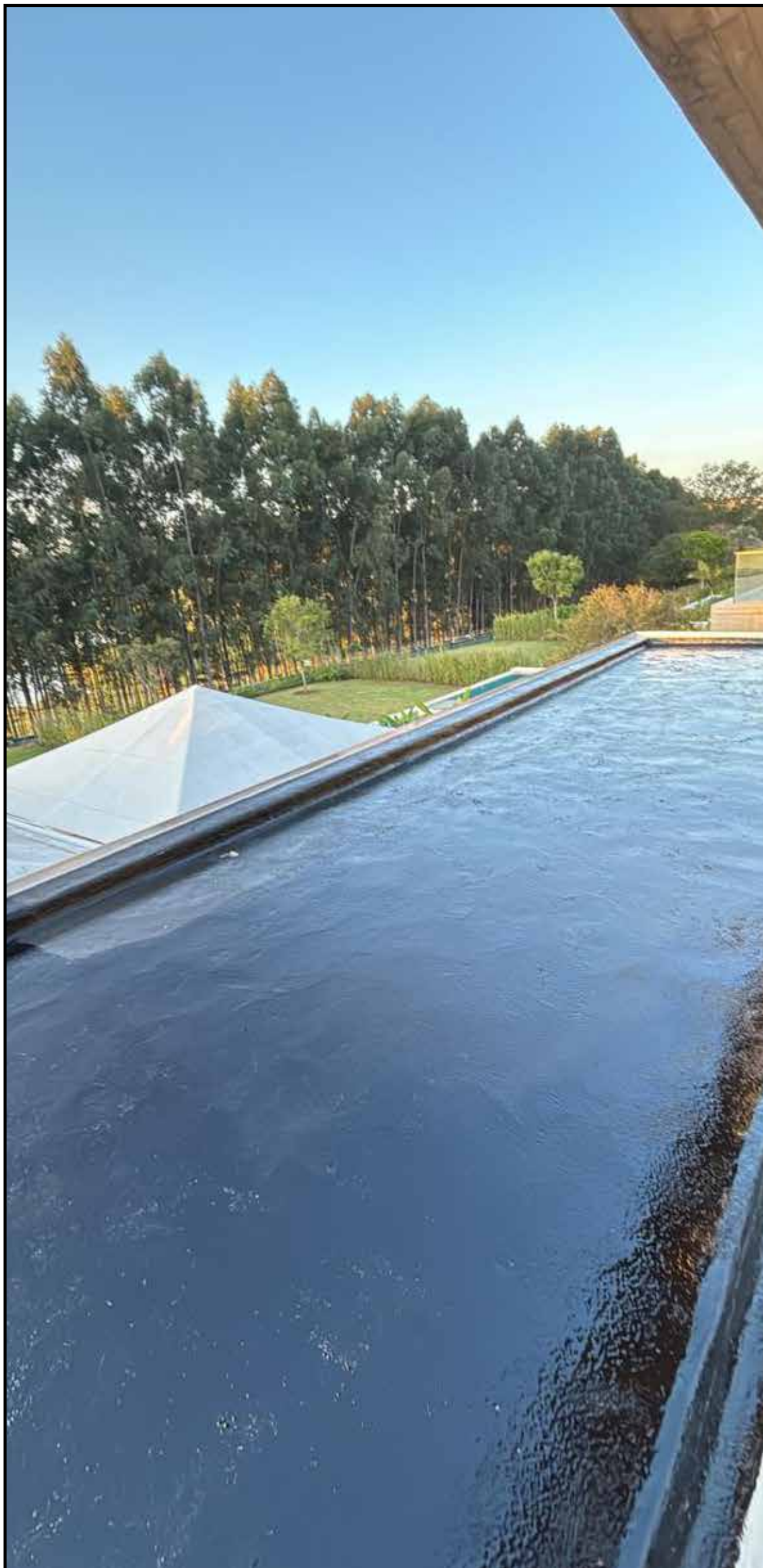
TESTE DE ESTANQUEIDADE VARANDA MASTER
