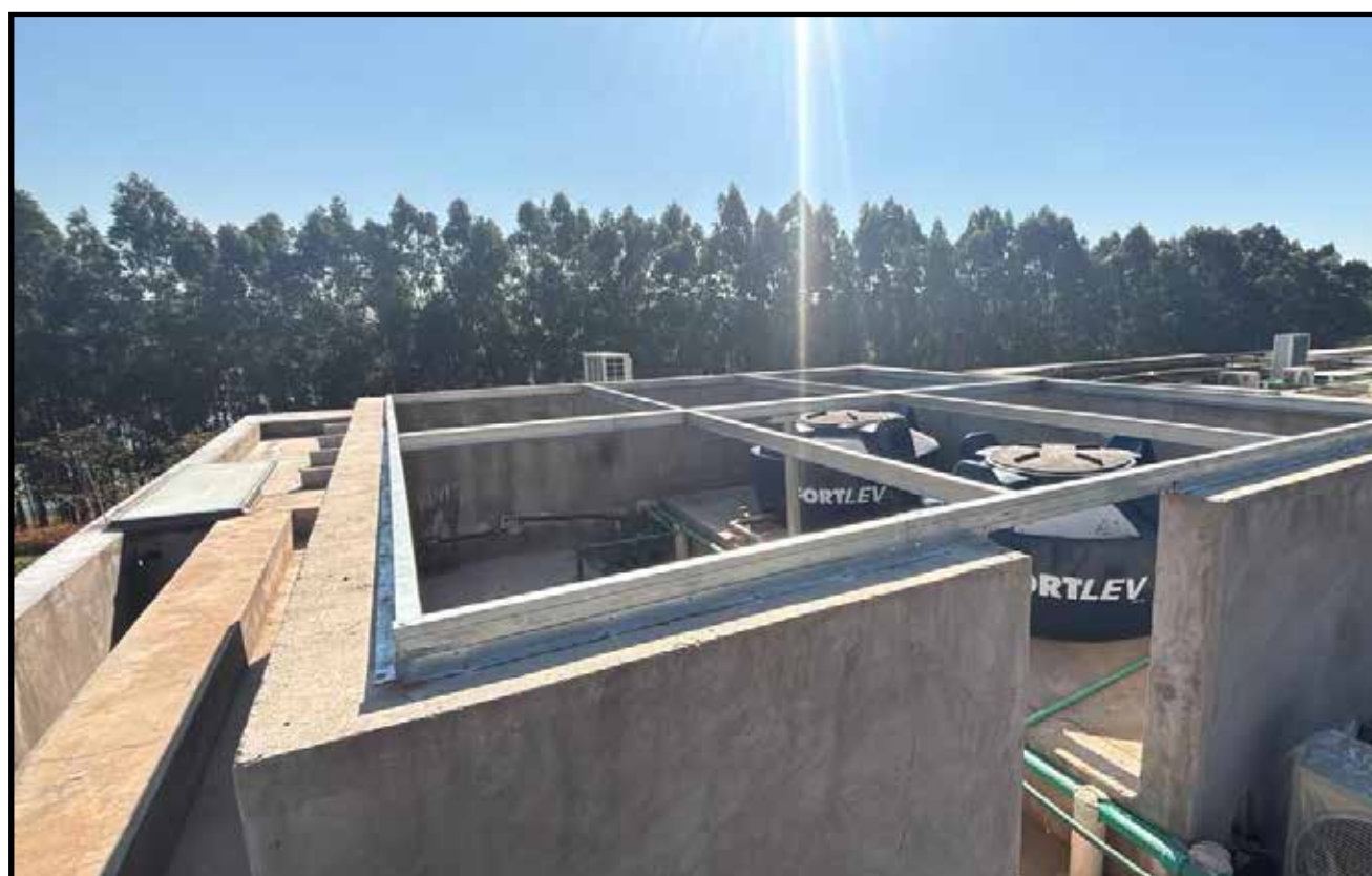
EXEC. ESTRUTURA STEEL FOTOVOLTAICO
