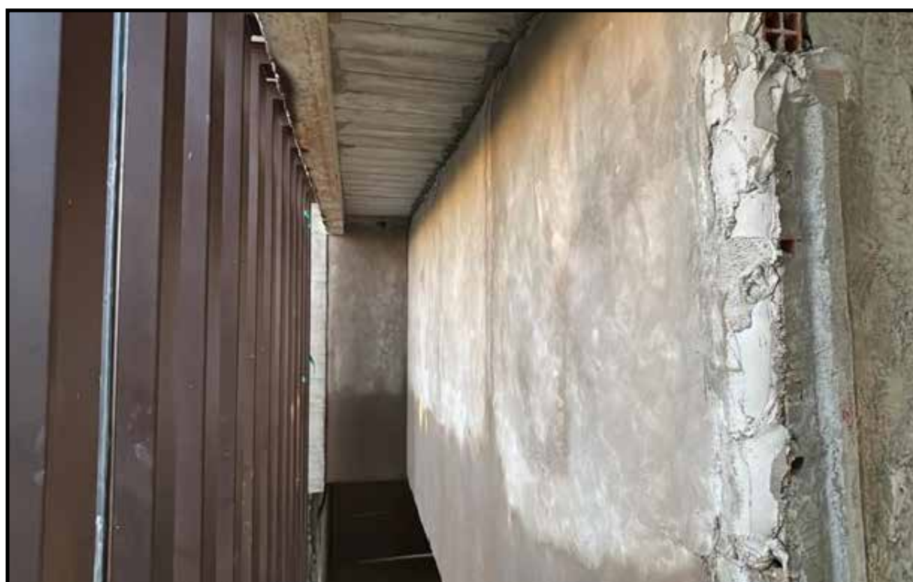
REGULARIZAÇÃO ALVENARIA ESCADA
