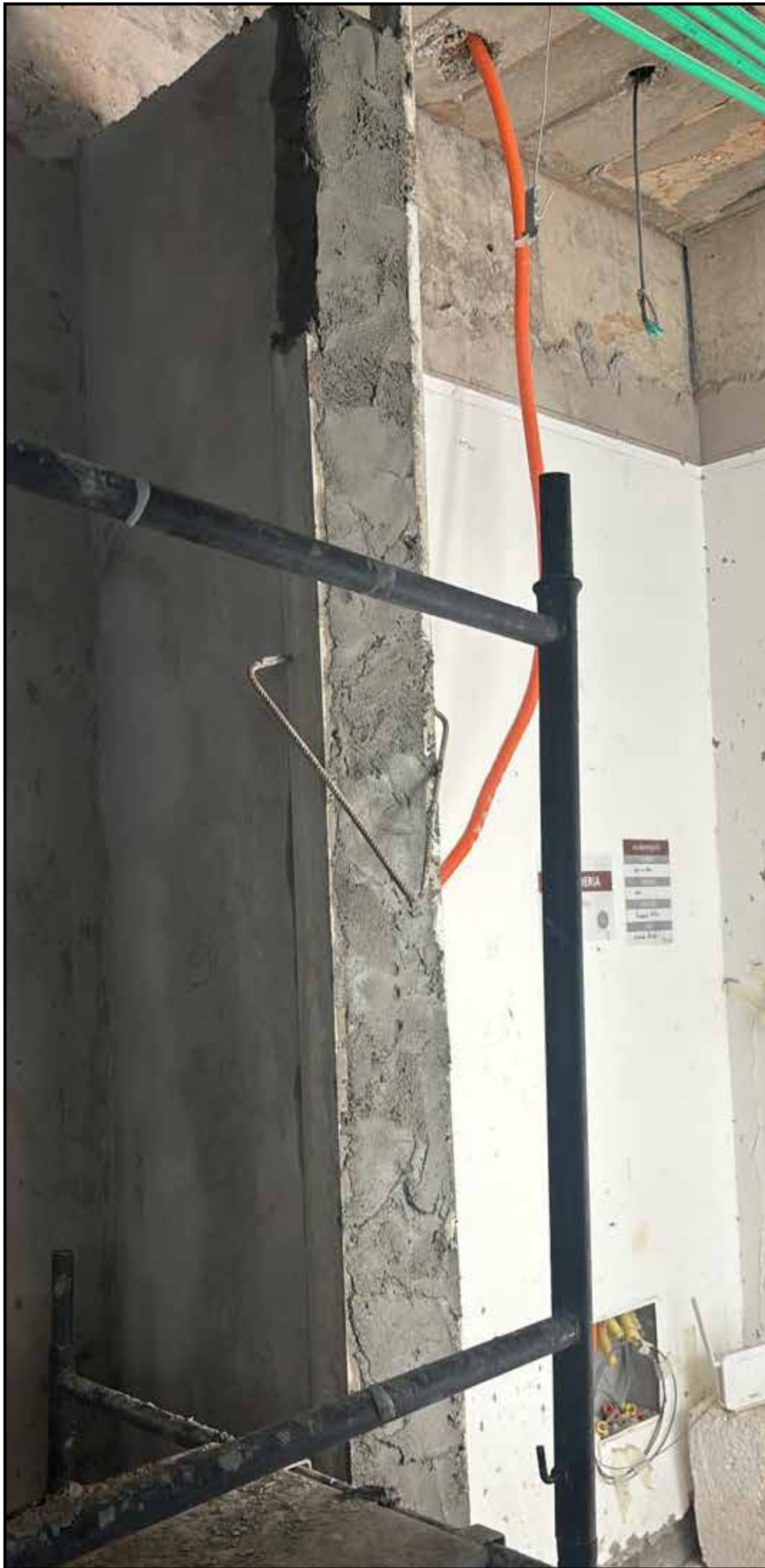
EXEC. ALVENARIA COZINHA
