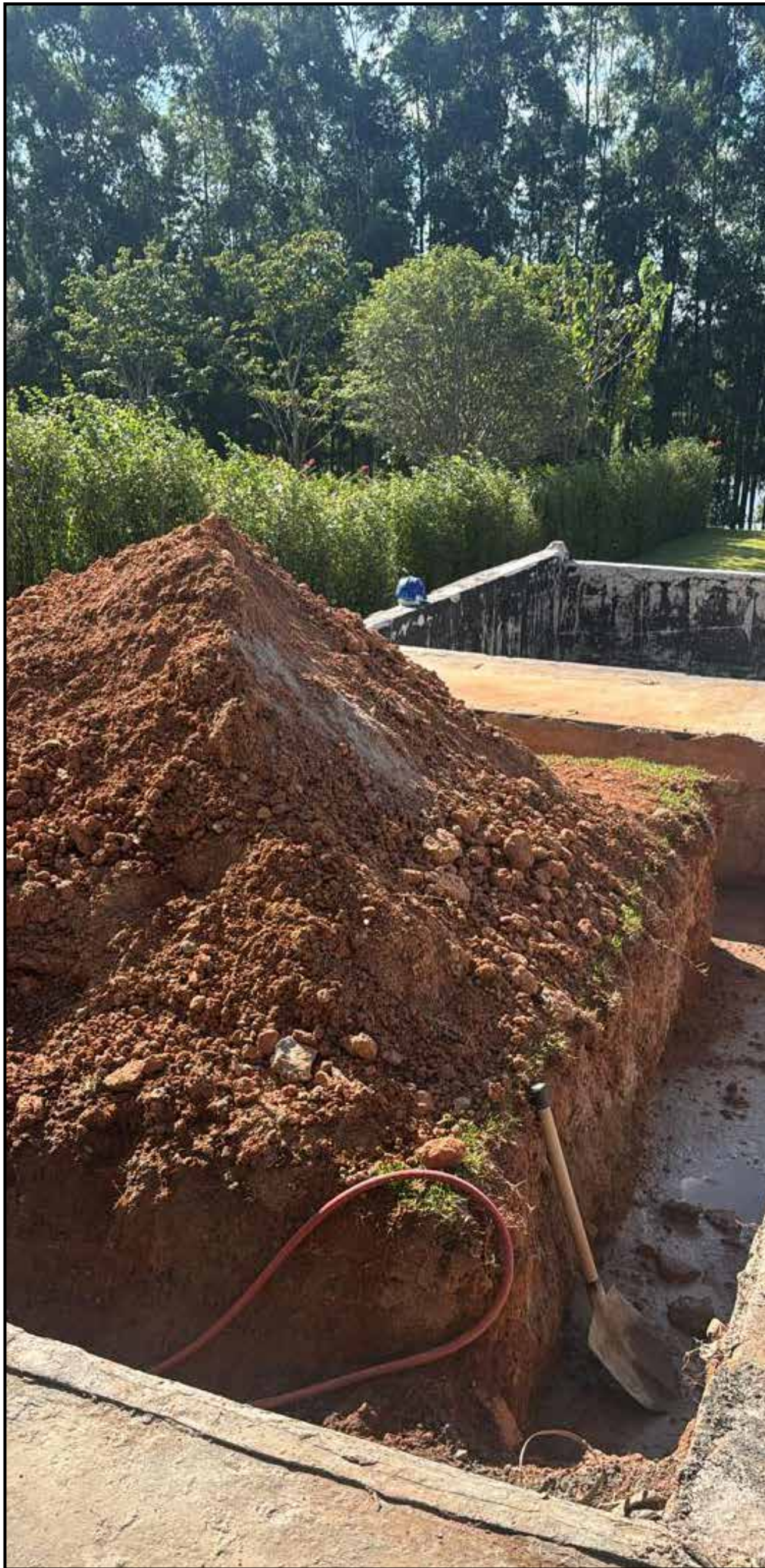
ESCAVAÇÃO LATERAL DECK PARA IMPER.
