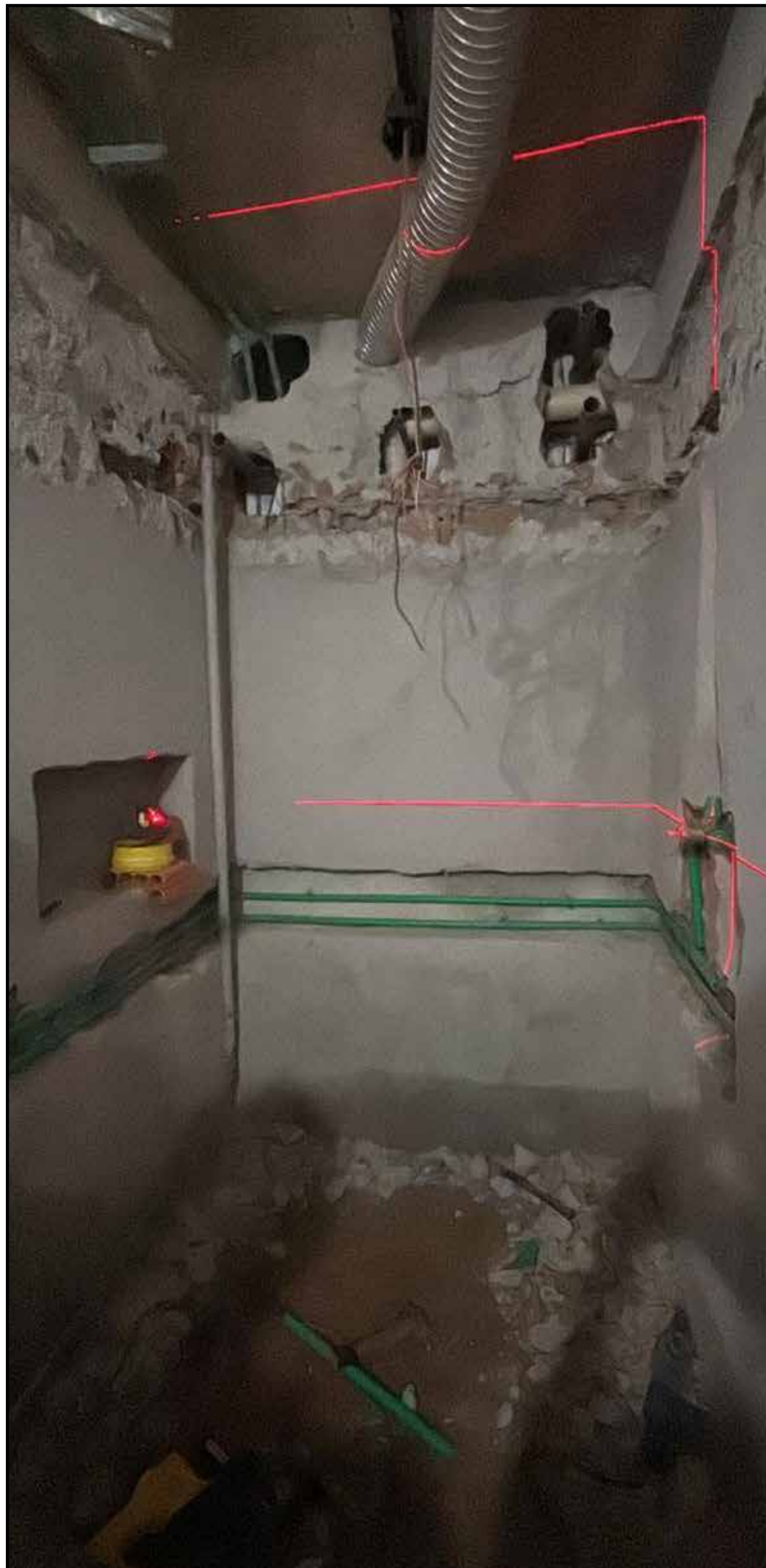
INFRA HIDRÁULICA BANHO SERVIÇO 2
