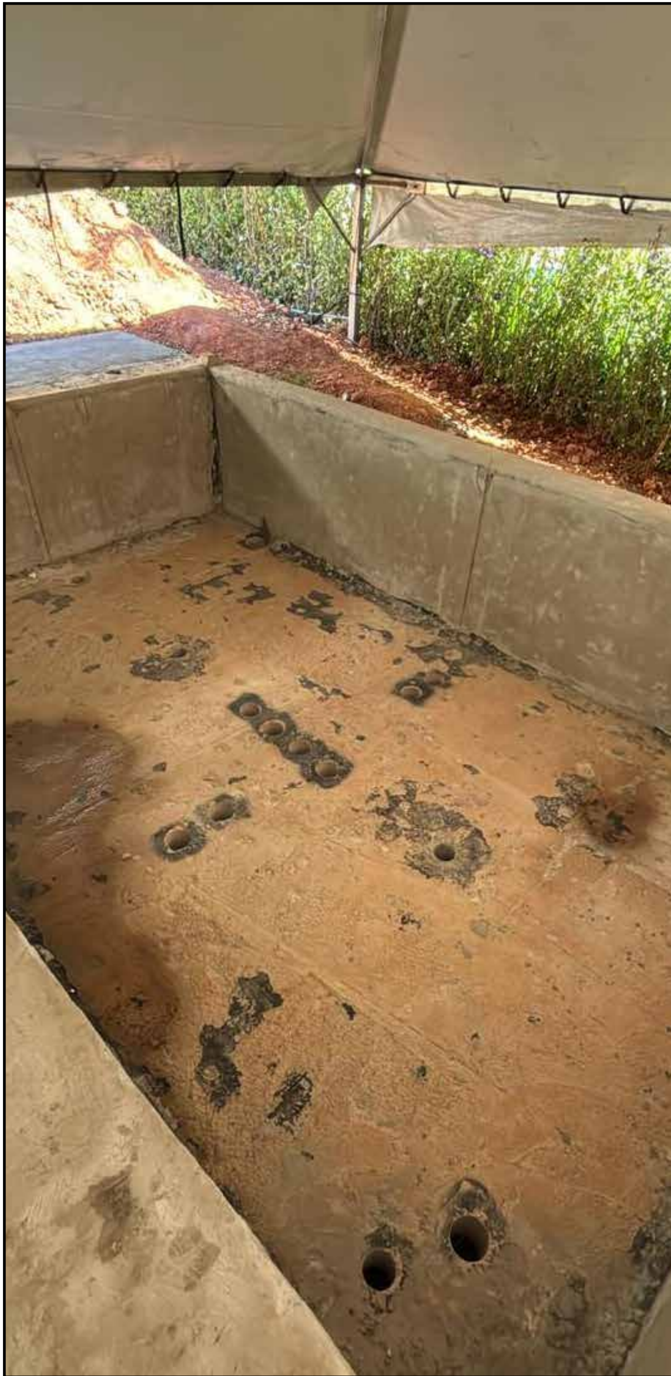
FURAÇÃO INFRA SPA B
